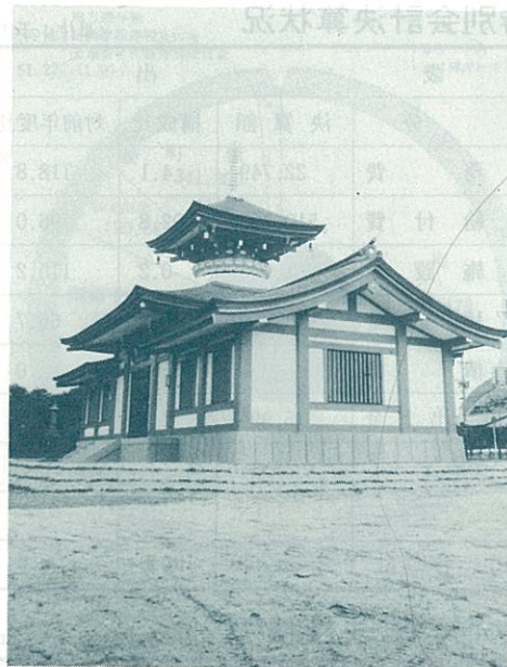
▲ 完成した長洲霊堂
